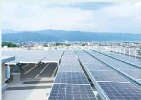
屋上には太陽光パネルを240枚(210W/枚)設置し、最大約50kWの発電を行います。災害等で停電になった場合には、自家発電機による非常用電源の供給を行います。各階に設置した太陽光発電専用のコンセントも非常用として活用できます。
