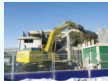
蚕糸博物館・美術考古館解体工事
