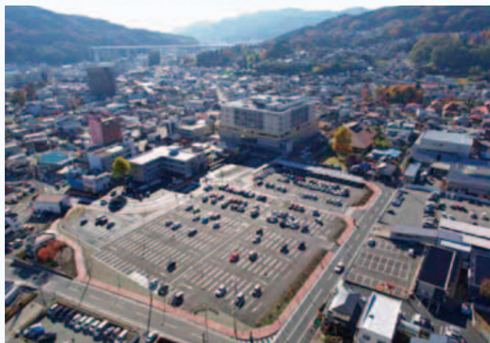
駐車場整備完了（H28.11月）
