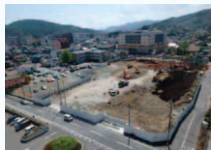
解体終了（H28.5月頃）
